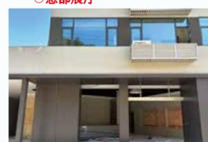
总部展厅墙面艺术漆及吊顶涂料打磨基本完成，展示台已见雏形。
